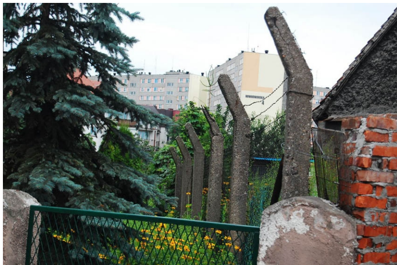
Zachowane ogrodzenie stacji zagłuszającej
